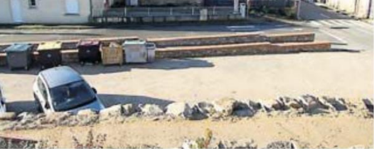
La restauration du bourg centre avec l'aménagement du secteur de la côte du Pigeonnier qui a déjà commencé par la création de la place. /Photo DDM
